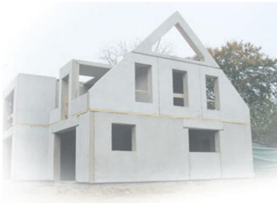
Использование насыпного пеностекла для получения пеностекло-бетонных легковесных монолитных конструкций (с сайта www.poraver.com )
