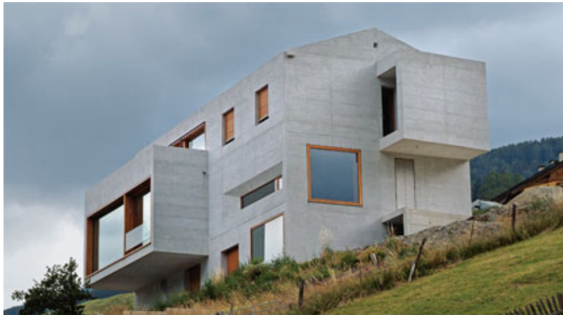
Использование насыпного пеностекла для получения пеностекло-бетонных конструкций (с сайта www.misapor.com )
