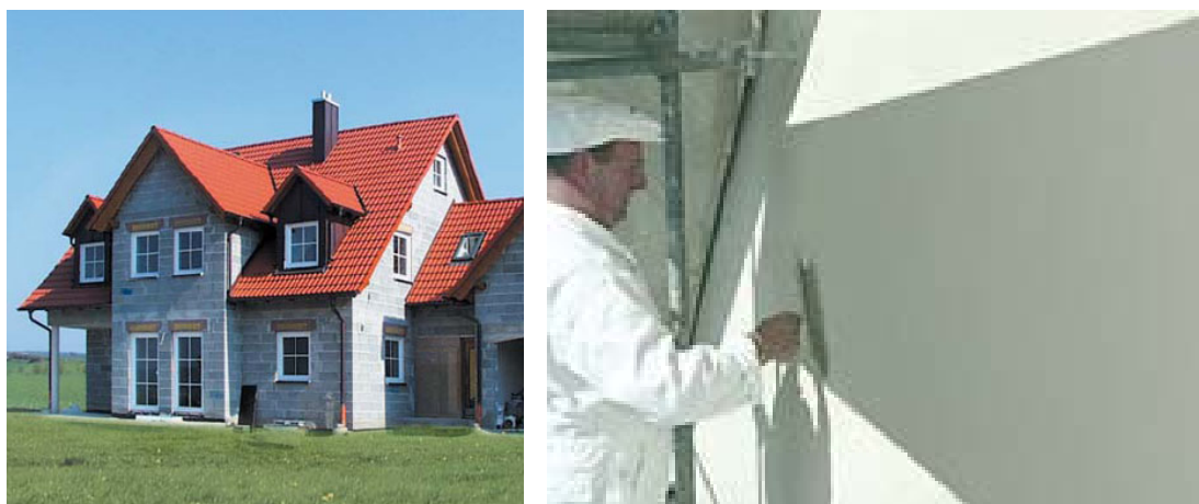
Построенный дом из пеностеклобетонных блоков и его отделка штукатуркой (с сайта www.poraver.com )
