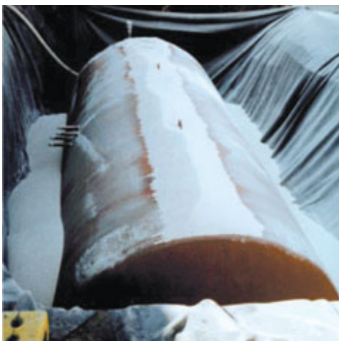
Теплоизоляция промышленного оборудования (с сайта www.poraver.com )
