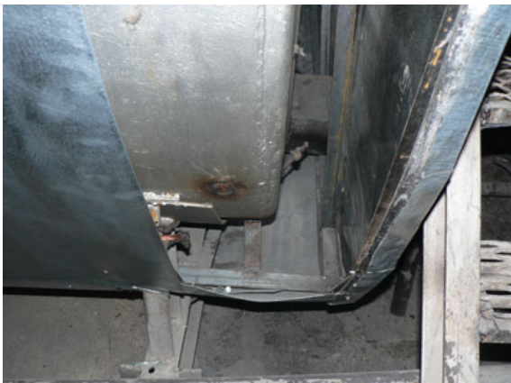
Монтаж опалубки поверх ёмкости
