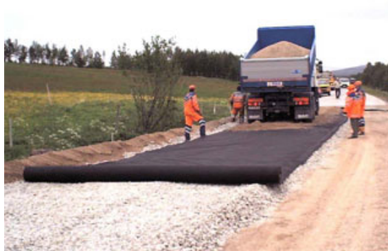
Строительство дороги в Норвегии с использованием насыпного пеностекла в качестве теплоизоляционного слоя
